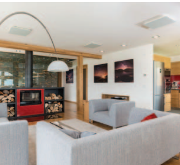
Sálavé panely ze skla na stěně a stropu
