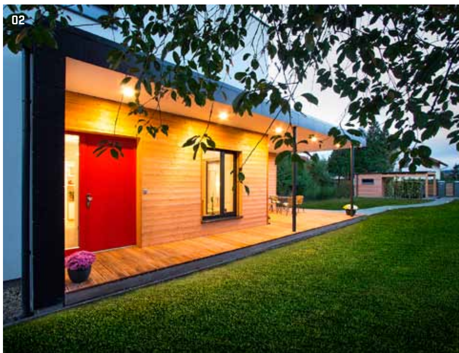
02 > Na západní části terasy se nacházejí vstupní dveře
