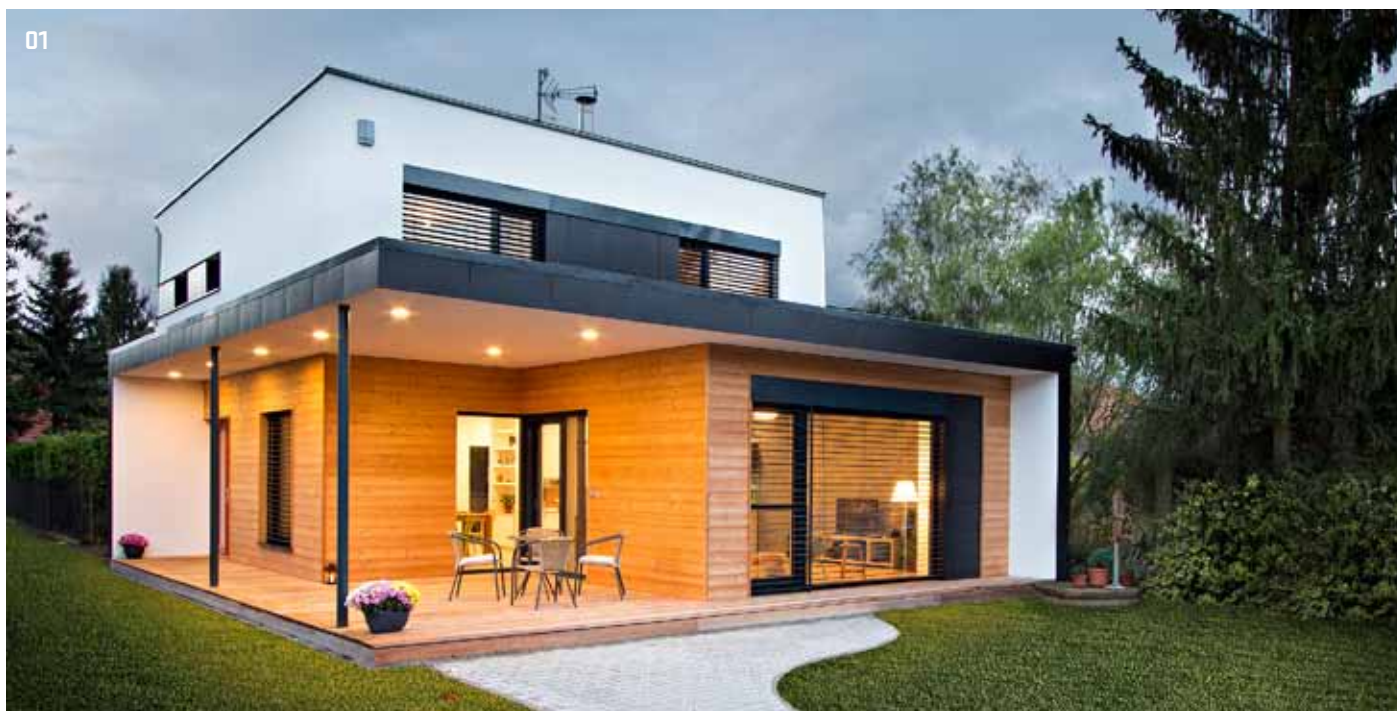
01 > Jádrem domu tvoří bílý kvádr, z něhož vystupuje dřevěná hmota obývacího pokoje
