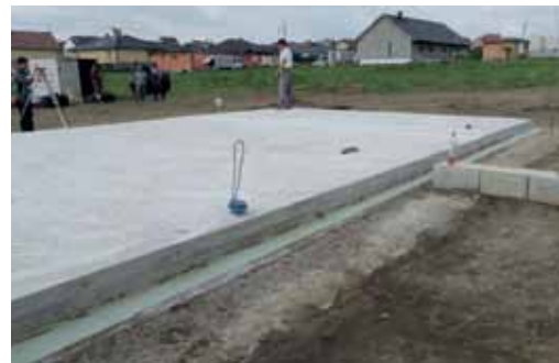
Základová železobetonová deska
