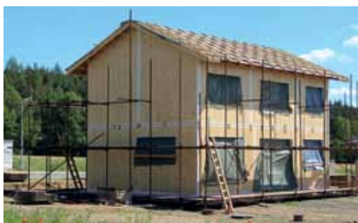
Střecha s pojistnou hydroizolací, zateplení soku
