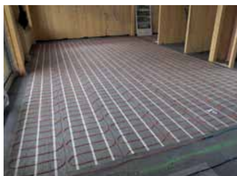
Instalace podlahového vytápění
