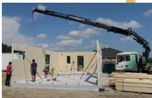
Svislé nosné konstrukce dolní podlaží
