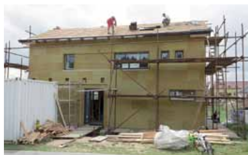
Zateplení fasády, práce na střeše
