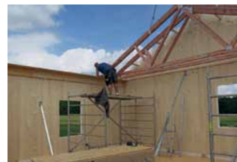
Realizace střešní konstrukce ze sbíjených vazníků
