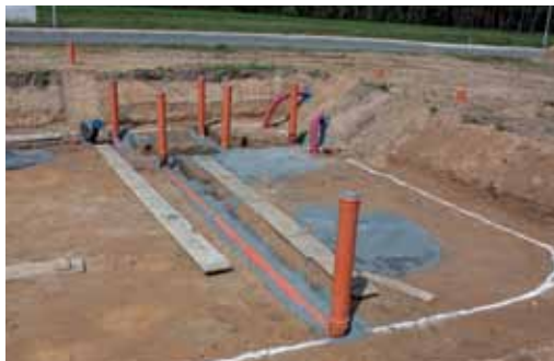
Rozvody ležaté kanalizace
