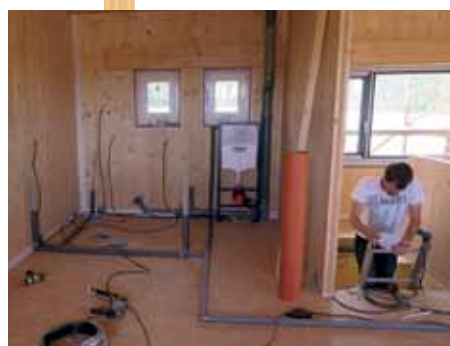
Realizace ZTI, odvětrání radon, stoupačky VZT
