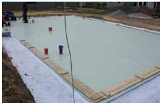
Aplikace foliové hydroizolace na vrstvu pěnoskla
