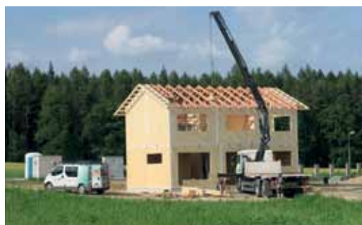
Realizace střešní konstrukce ze sbíjených vazníků
